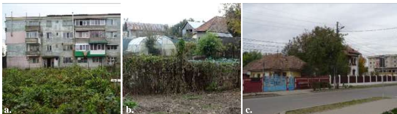
Fig. nr. 3.38 Aspecte ale fondului de locuințe din Municipiul Băilești: a. locuințe colective (uzura fondului, discordanțele arhitectonice, lipsa infrastructurii tehnico-edilitare), b. locuințele individuale de tip rural, cu anexe gospodărești și grădini cultivate, c. interferențe ale locuințelor individuale nemodernizate/modernizate cu locuințele colective din arealul central
