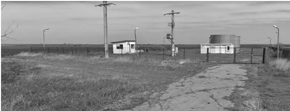
stația de pompare situata in extravilanul sat Grecești
