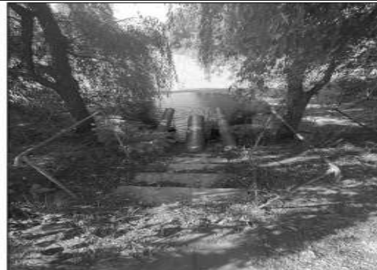
Evacuare ape din prea plinul Lacului Tanchiștilor 2 spre balta Cernele
