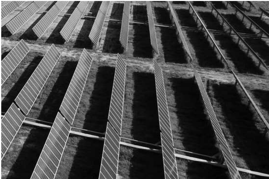
Figura 5. Exemplificare amplasare șiruri de panouri pe sol
