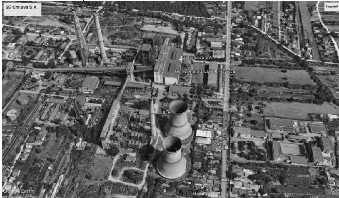
Figura 1 Vedere din satelit – Amplasamentul Societății Electrocentrale Craiova S.A.
