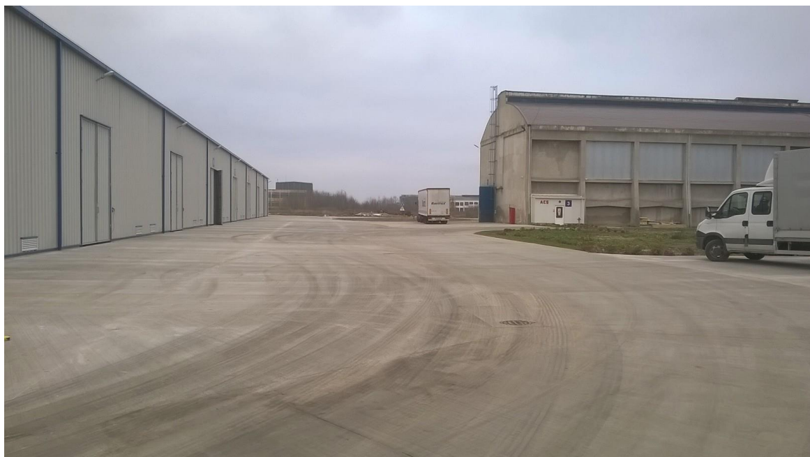
Foto nr.1 Vedere spre amplasamentul depozitului de ingrasaminte chimice, Hale existente C3 din beton si C8 cu invelitoare metalica
