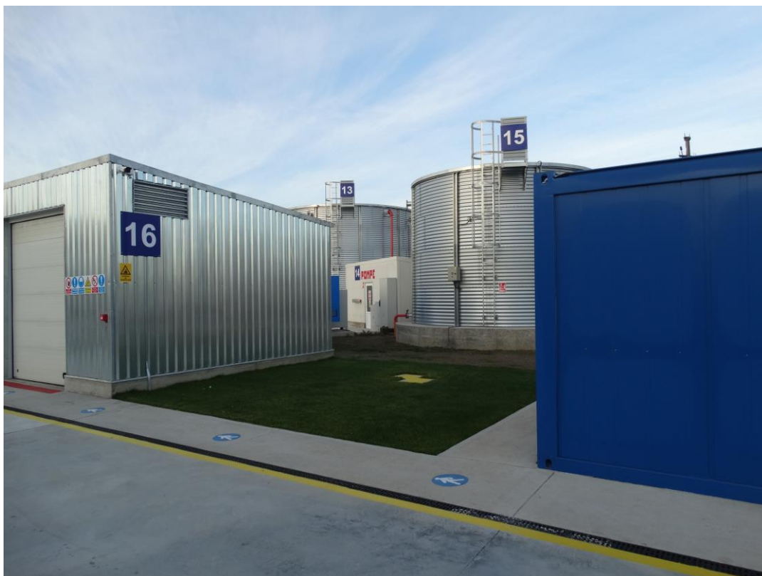
Foto nr.2 Hale de depozitare ingrasaminte chimice, garaj, sistem de gospodarie a apei (statie de pompe si 2 rezervoare)
