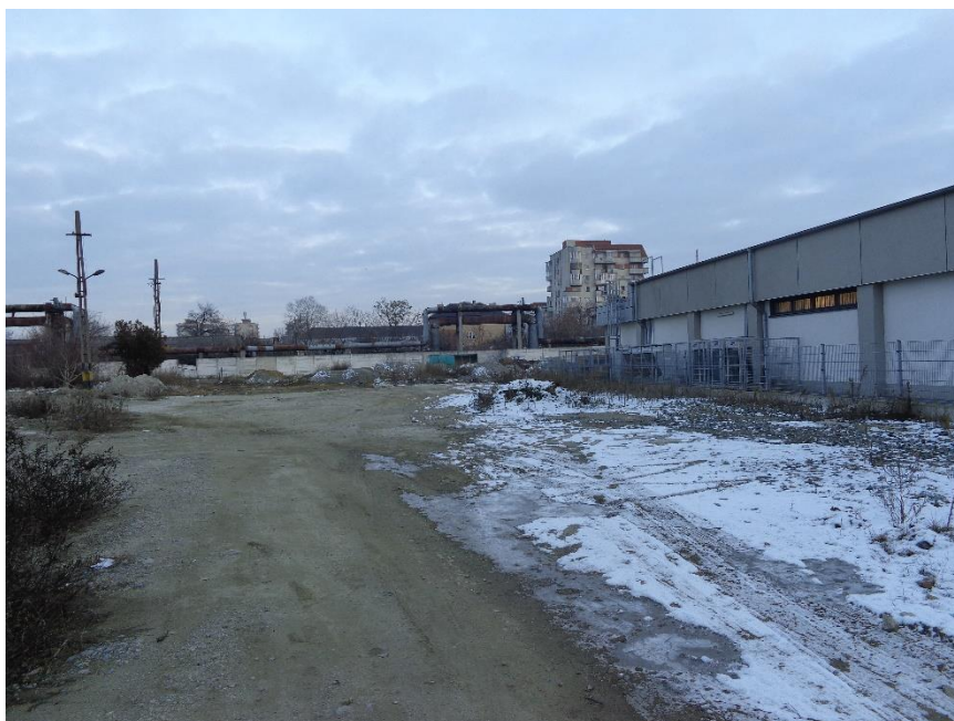
Figura 6 Zona de acces din strada Sararilor spre Est
