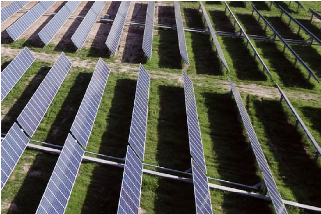
Figura 5. Exemplificare amplasare șiruri de panouri pe sol
