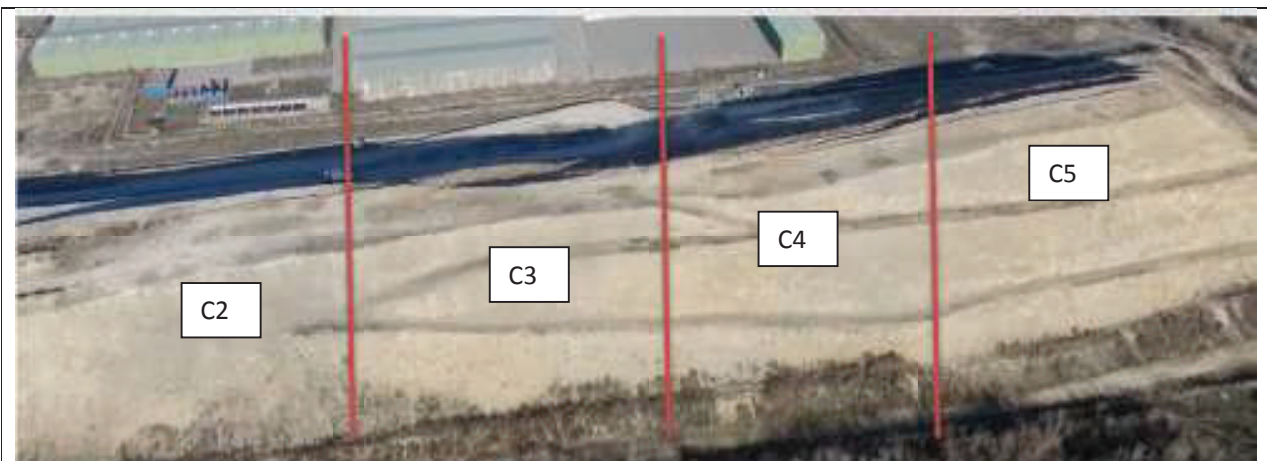
Corpul depozitului este un tot unitar, nu se poate face distictia clar documentat intre celule
